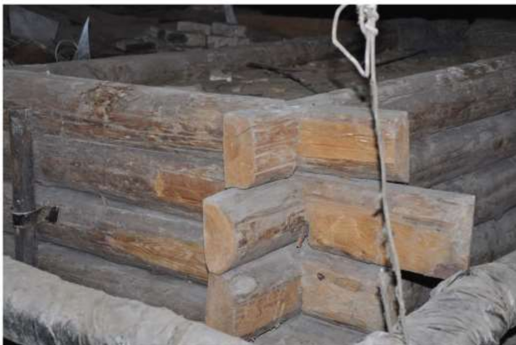
49. Сруб в обло на чердаке северной части здания.
