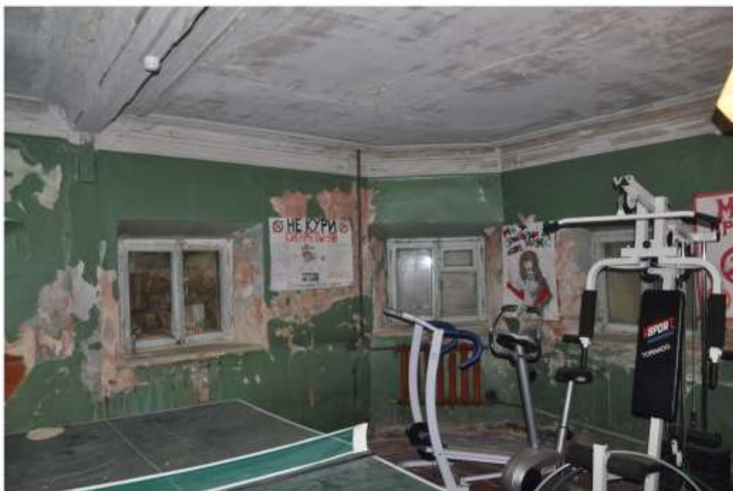
41. Цокольный этаж, угловое помещение в северной части здания.
