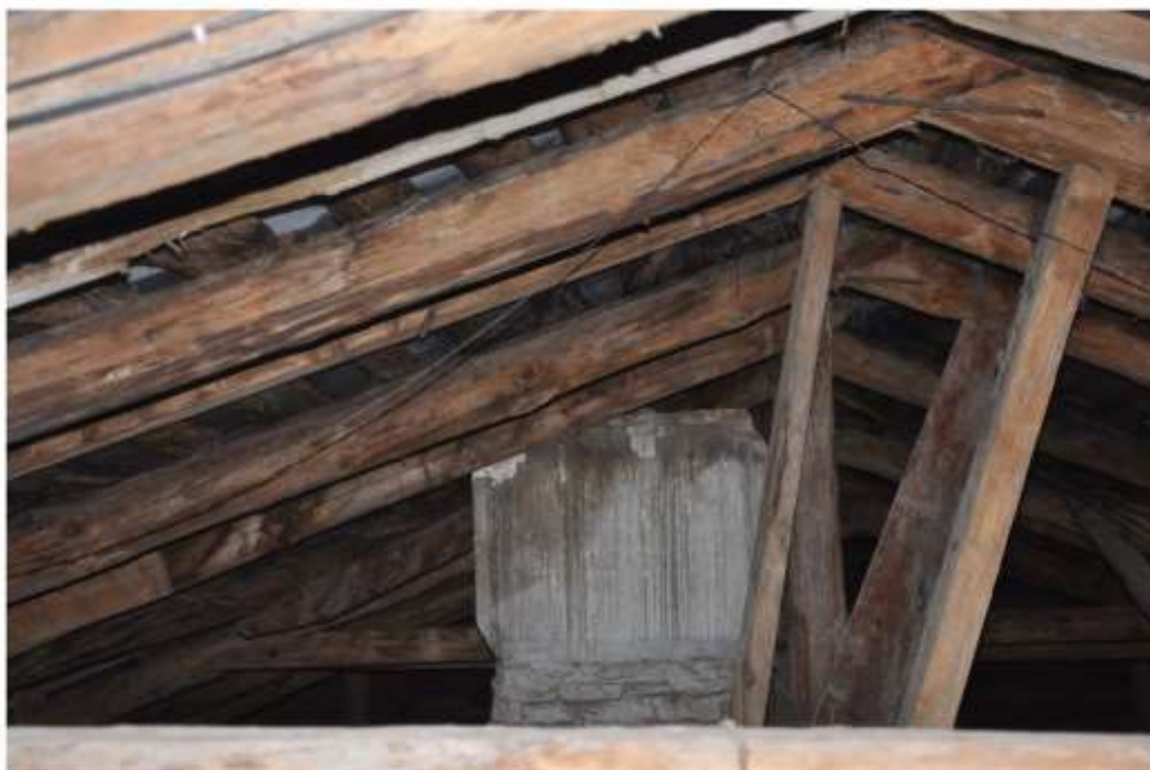
48. Подкровельное пространство северной части здания.
