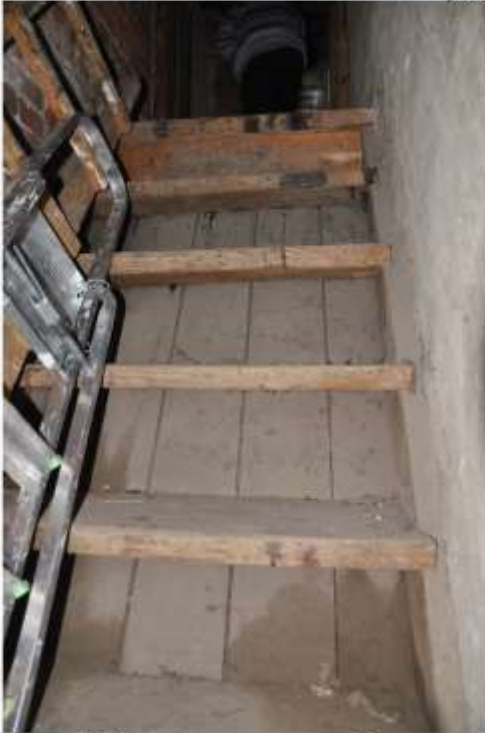
46. Лестница на чердак, нижний марш.
