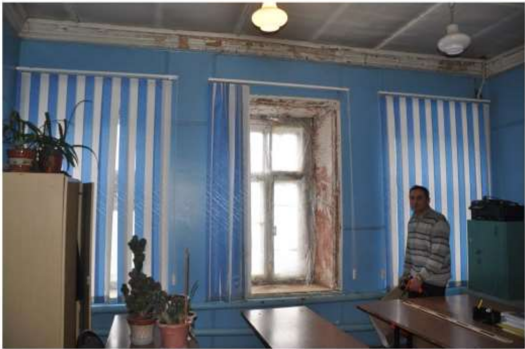
31. Западное помещение в северной части здания.
