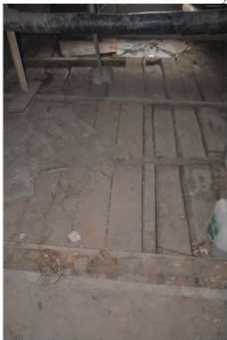
54. Доплатый пол в подкровельном пространстве южной части.
