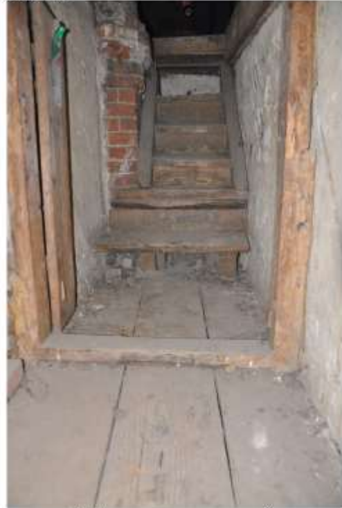
47. Лестница на чердак, верхний марш.
