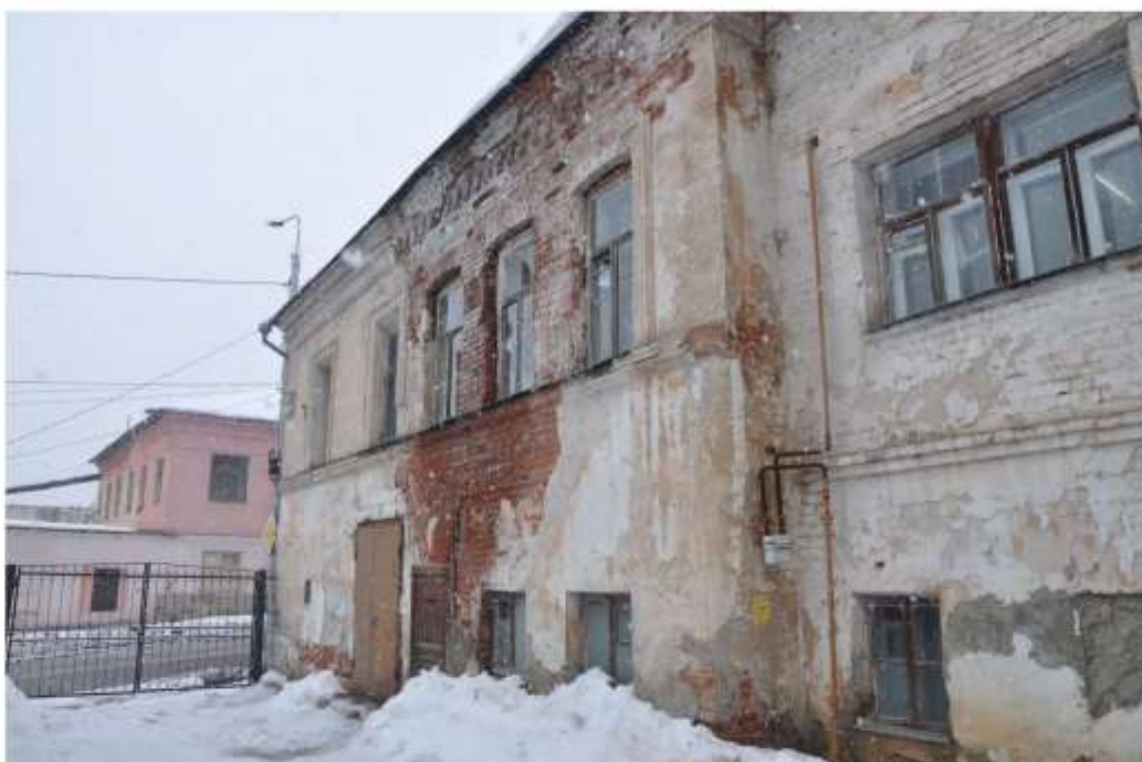
4. Западный фасад, северная часть
