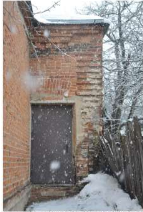
8. Штраба для пристройки кирпичной стены.
