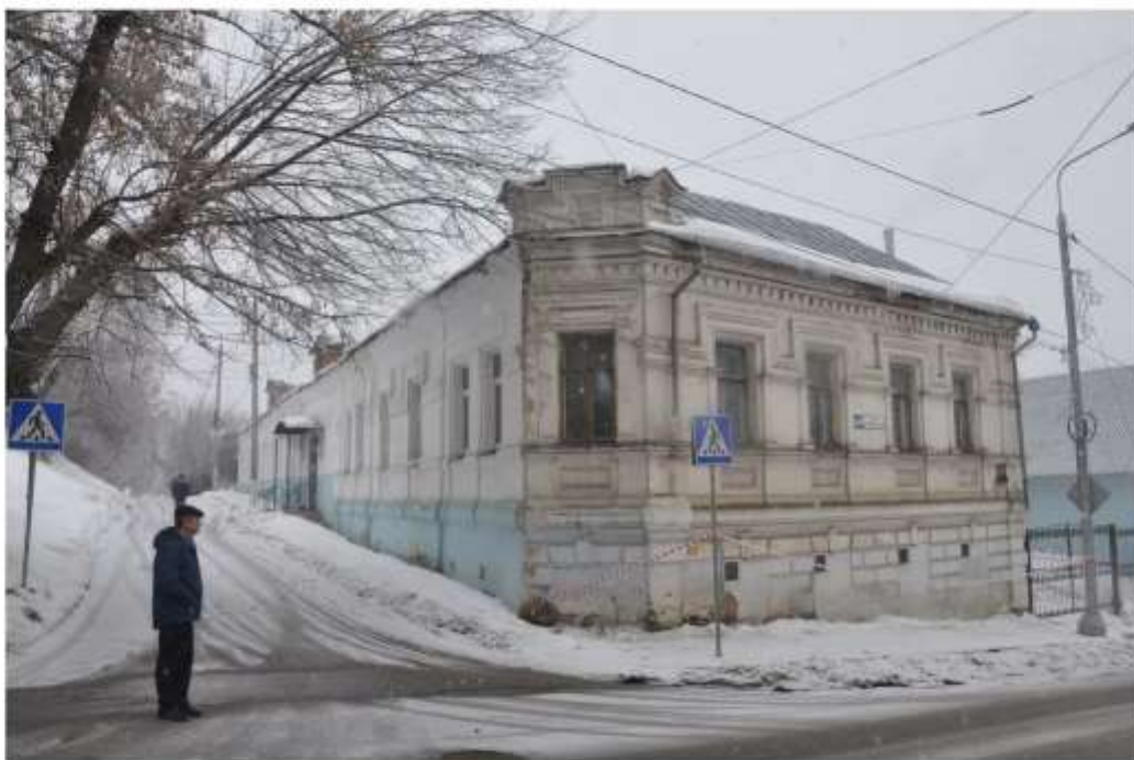
1. Общий вид с северо-востока.
