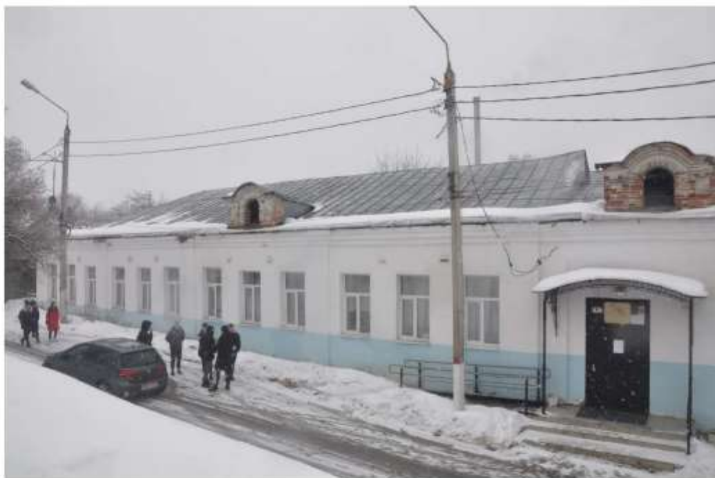
9. Восточный фасад, южная часть.
