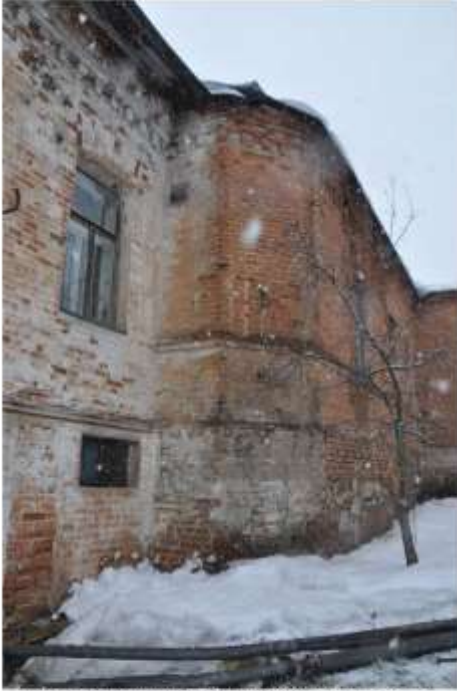
7. Северо-западный угол южной части здания
