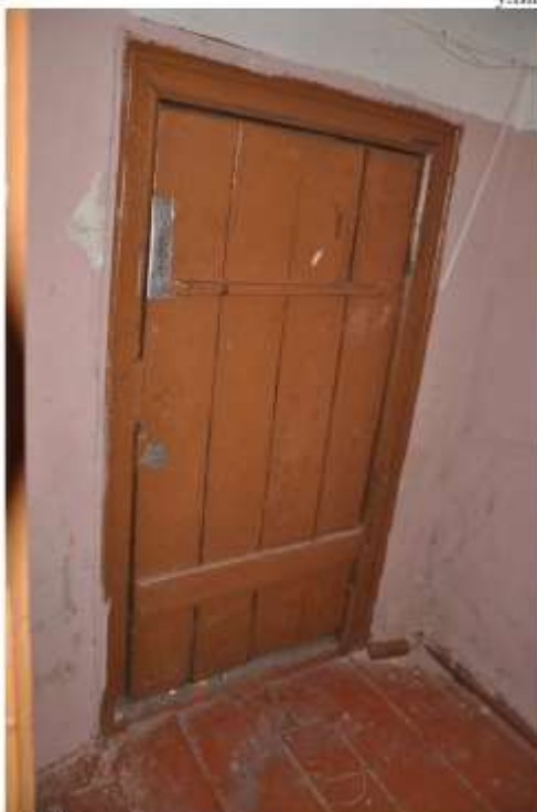
39. Щитовая дверь в техническое помещение цокольного этажа.
