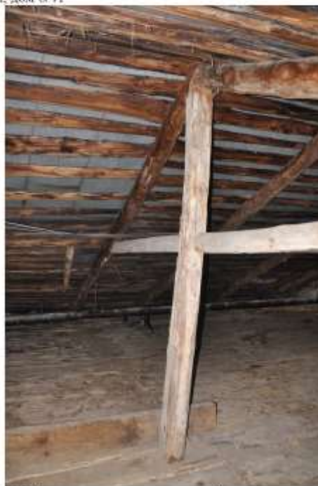
55. Стропильная система в южной части здания.
