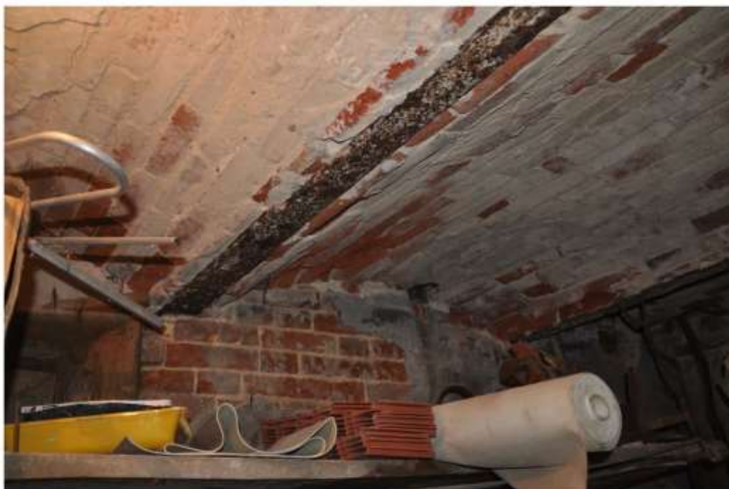
43. Междупэтажное перекрытие типа Монье в техническом помещении цоколя.
