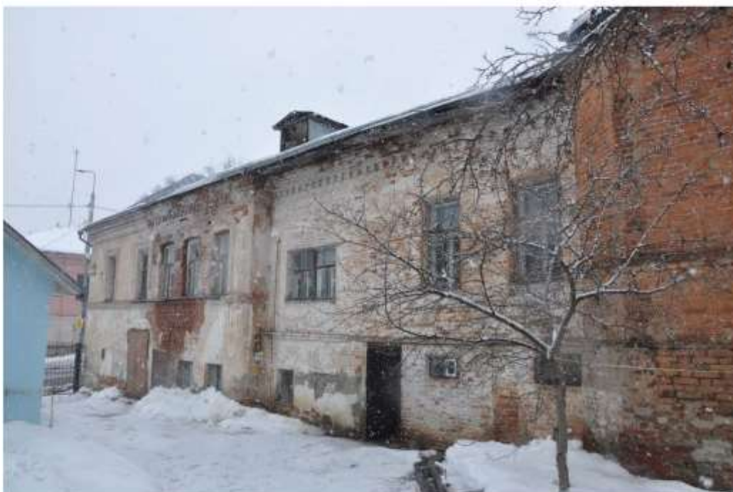
5. Западный фасад, северная часть.
