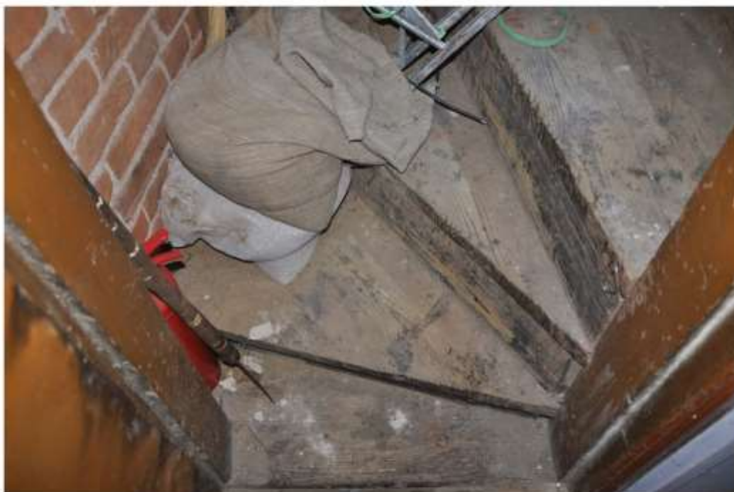
45. Нижняя забежная часть деревянной лестницы на чердак.
