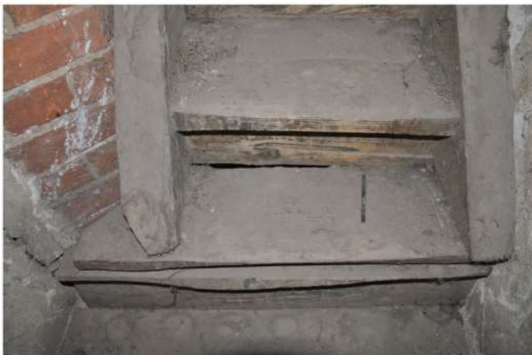
45. Лестница на чердак, фрагмент.
